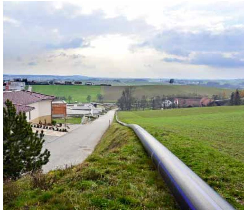
Die zweite Bohrung hatte eine Länge von 625 Metern. Im Bild: der vorgefertigte Rohrstrang. | Alle Fotos: Pfaffinger-Beermann PB Drill- & Energietechnik, Passau
